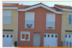
Hameau de la Maronnerie 64 logements
